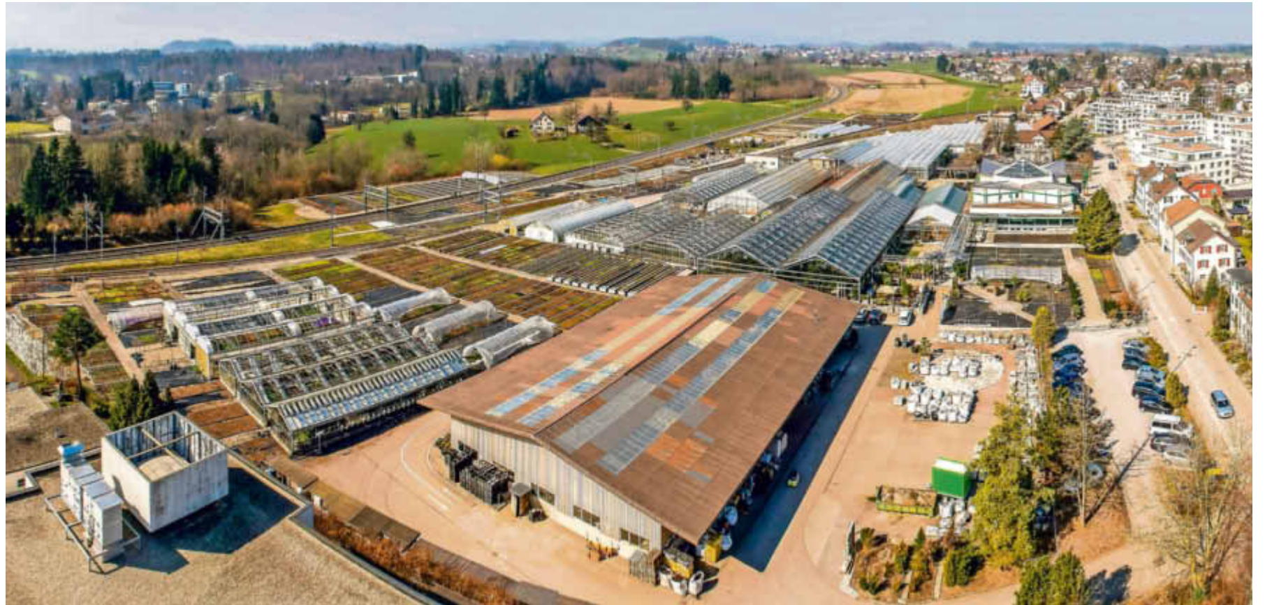
Laut Erwin Meier-Honegger vom Garten-Center Meier ist es an der Zeit, am Tanner Standort «aufzuräumen». Der private Gestaltungsplan Gärtnerei Tann leitet diesen Prozess ein. Auf dem Areal sollen sämtliche Gewächshäuser ersetzt und drei Mehrfamilienhäuser erstellt werden. Bild: Markus Zürcher
